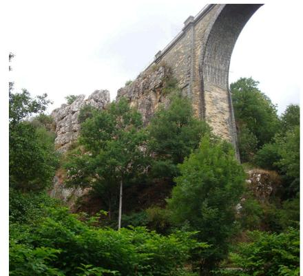
Le viaduc de Coquilleau en appui sur le pli pincé du grès ordovicien
